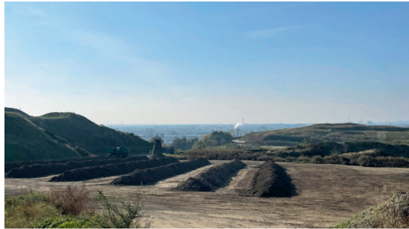
Abb. 6: Deponie Langes Feld, Herstellung Vererdungsmaterial, 2024
